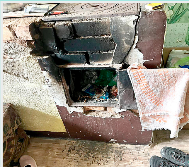
Отсутствует металлический (или из других негорючих материалов) предтопочный лист
